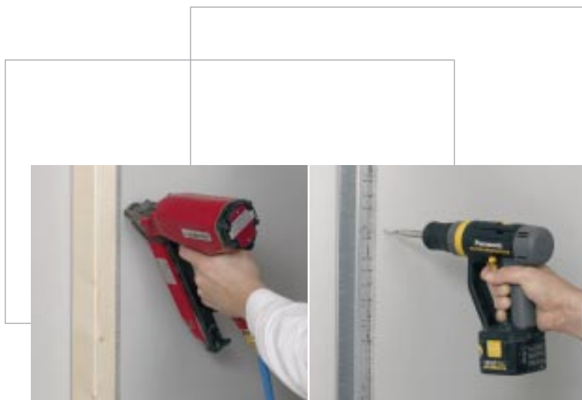
Klamrami lub wkrętami przymocować płytę do konstrukcji nośnej
