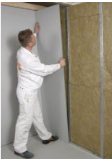
Montaż płyty
